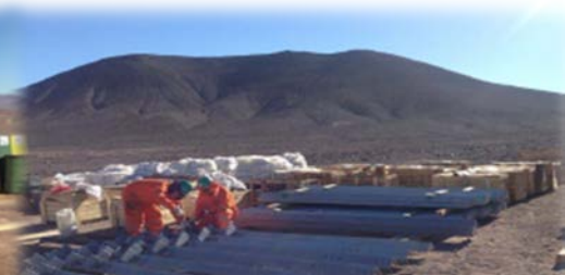
Patio preparación tubos
